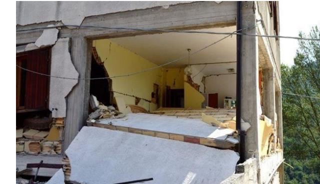
**Per evitare collassi fragili e prematuri e la possibile espulsione per carichi sismici inserire**
