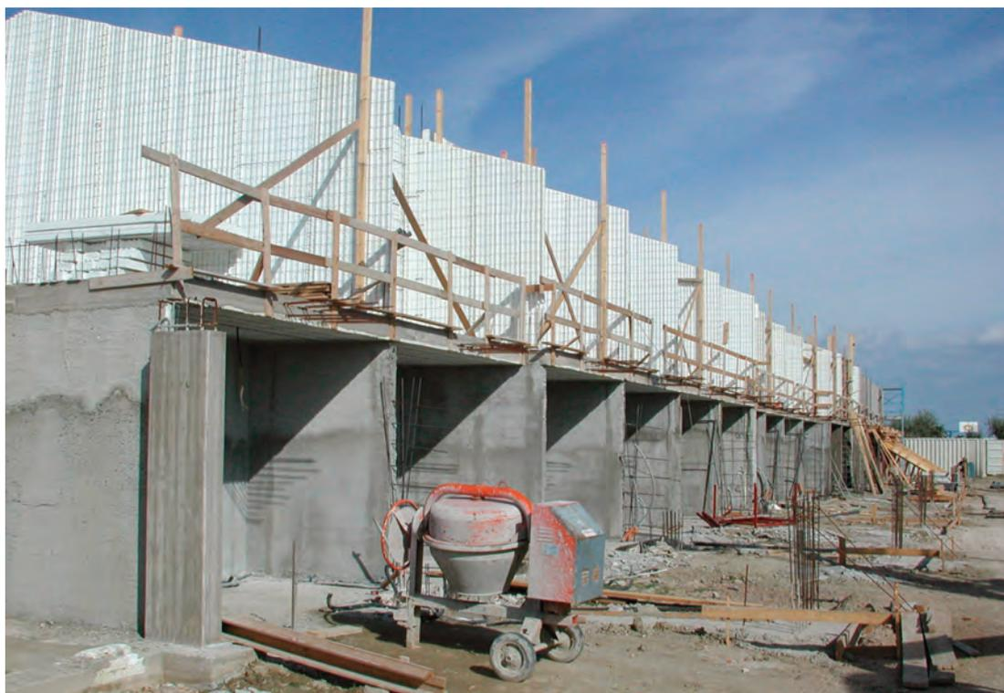
Figura 1.8 - Edificio in linea a due piani realizzato con pannello singolo portante.
